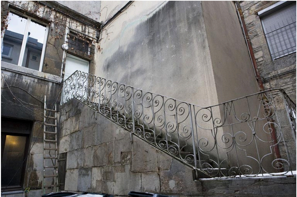
Détail d'un escalier extérieur situé dans la deuxième cour : 13 Grande Rue.
