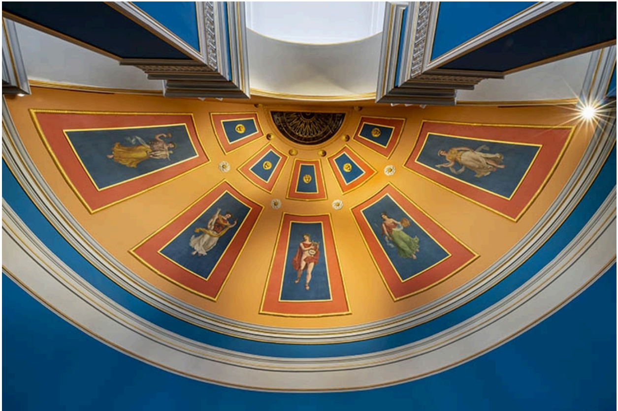
Foyer : fausse-voûte en cul-de-four de l'antichambre.
