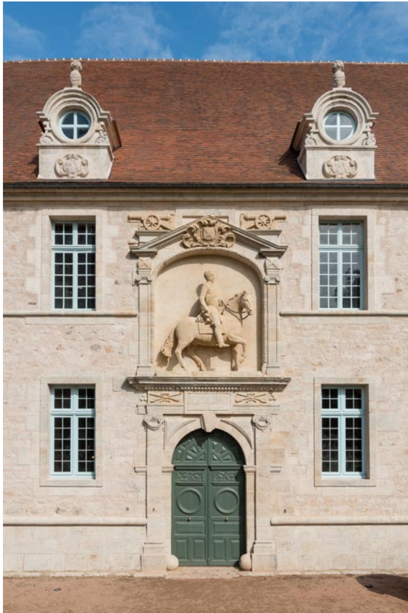
Façade sud-est, travée centrale, après restauration.
