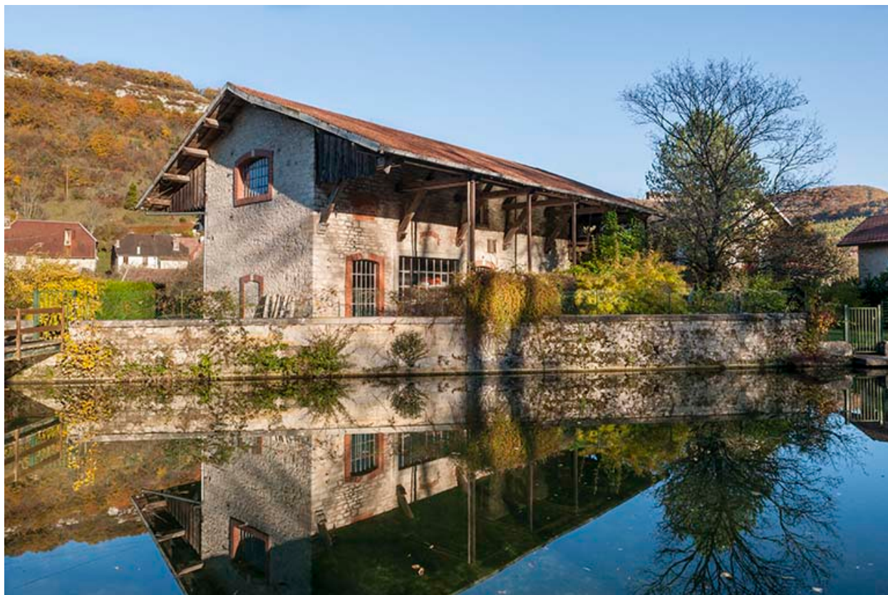
Entrepôt industriel vu depuis le nord-ouest.
