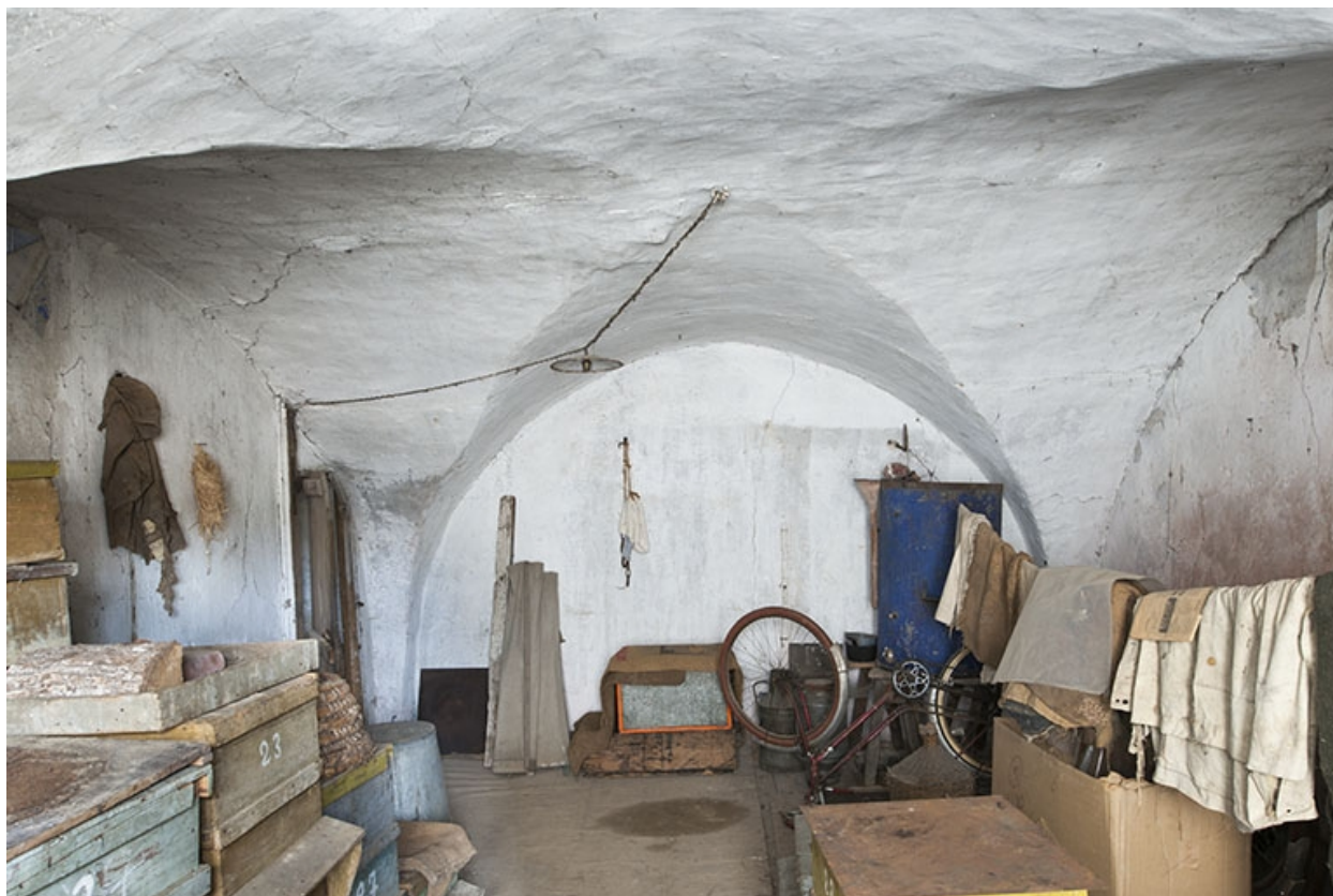
La seconde pièce, en direction de l'escalier.
