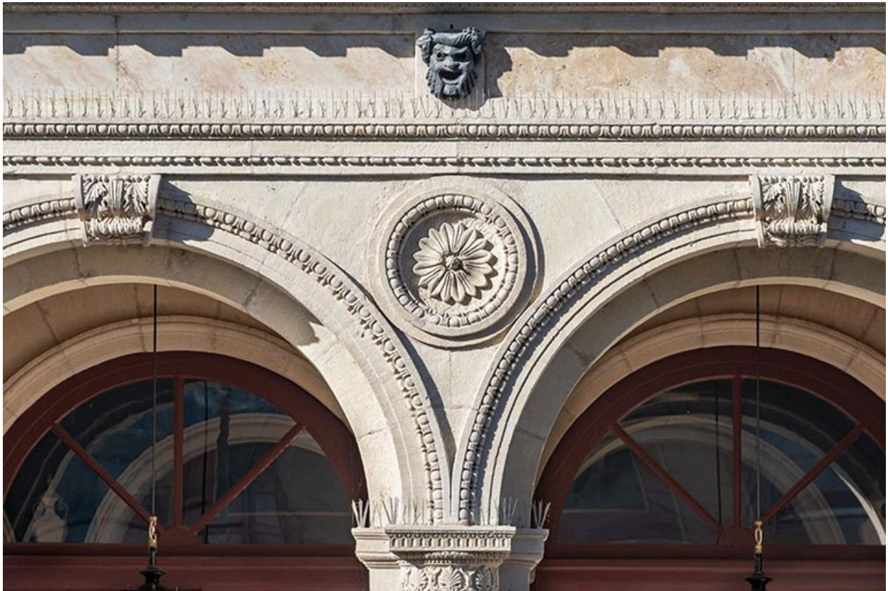
Façade antérieure, étage : décor.
