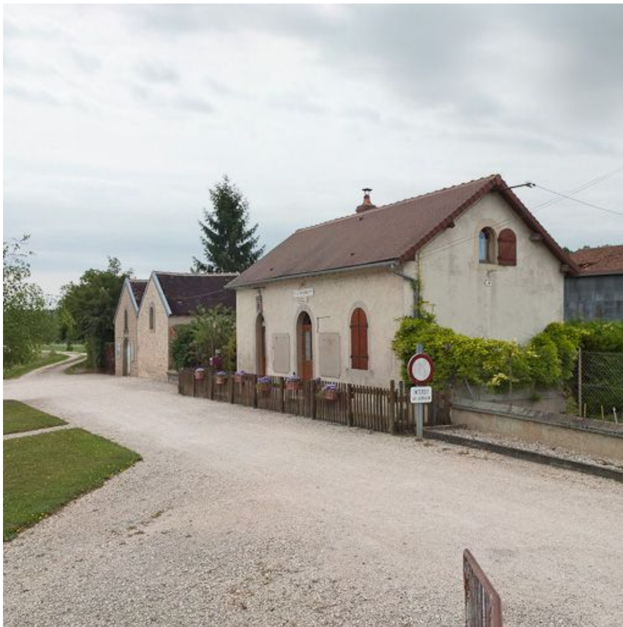
Vue de la maison éclusière.
