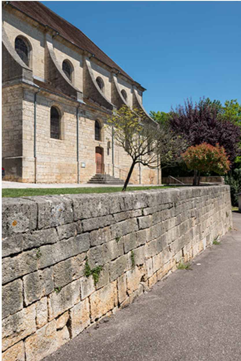
Flanc sud, mur de l'ancien cimetière.
