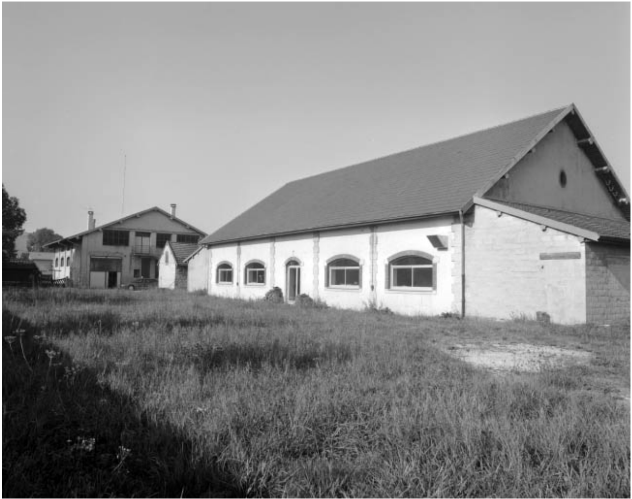
Façade postérieure de l'atelier de fabrication.
