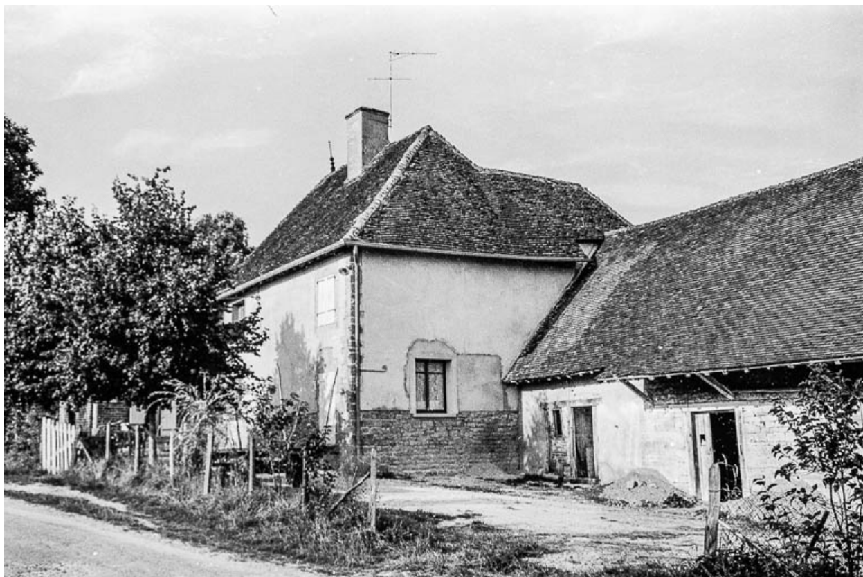
Ferme cadastrée 1811 D1 : vue de la partie habitation et d'une partie du bâtiment agricole.
