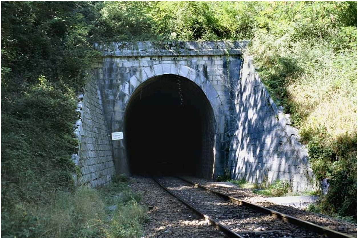
Tunnel d'Arbent 1 : tête côté La Cluse (sud-est).
