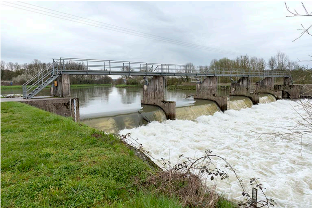
Le barrage mobile de Saint-Albin.
