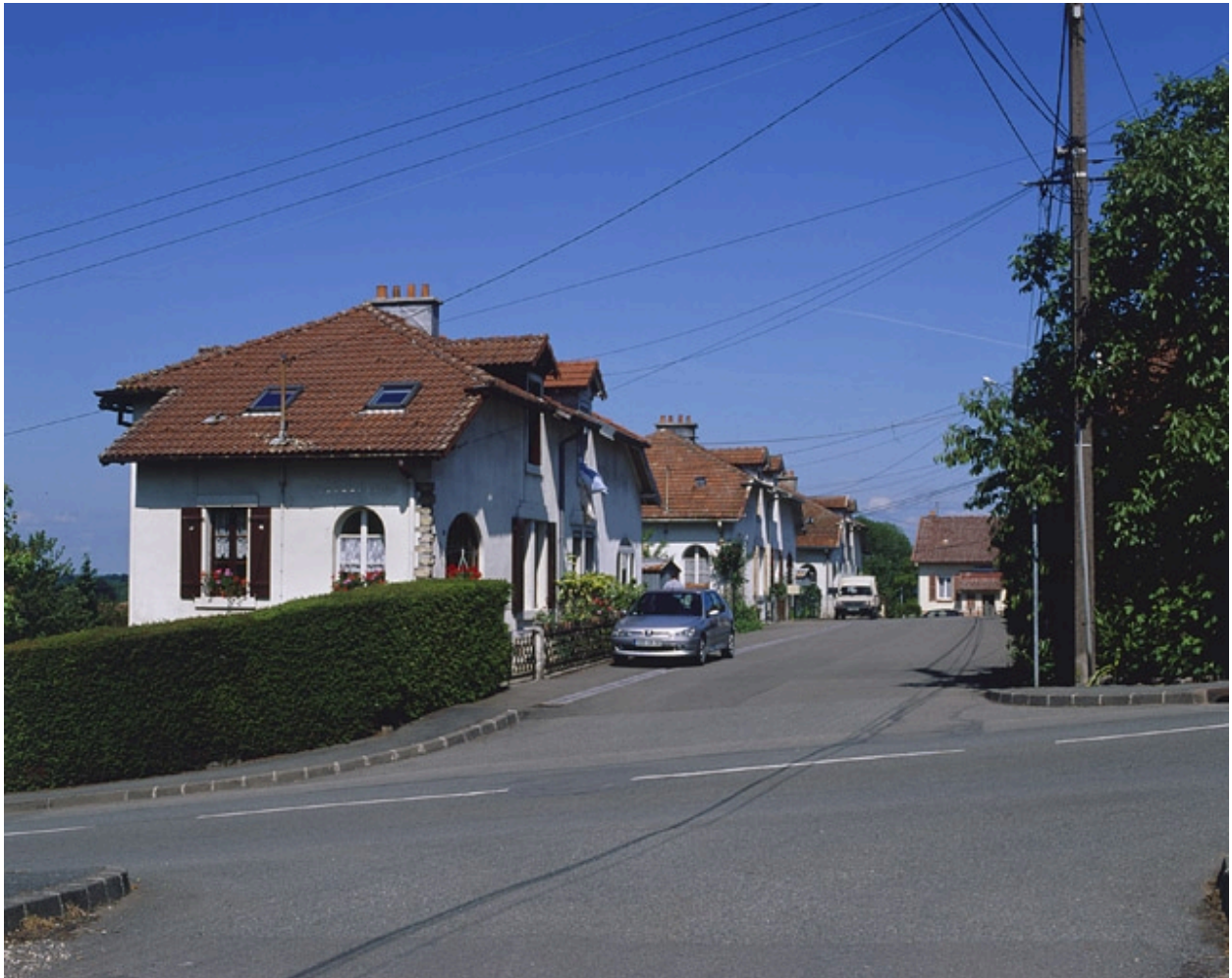
Vue de la rue des Fondeurs depuis l'est.
