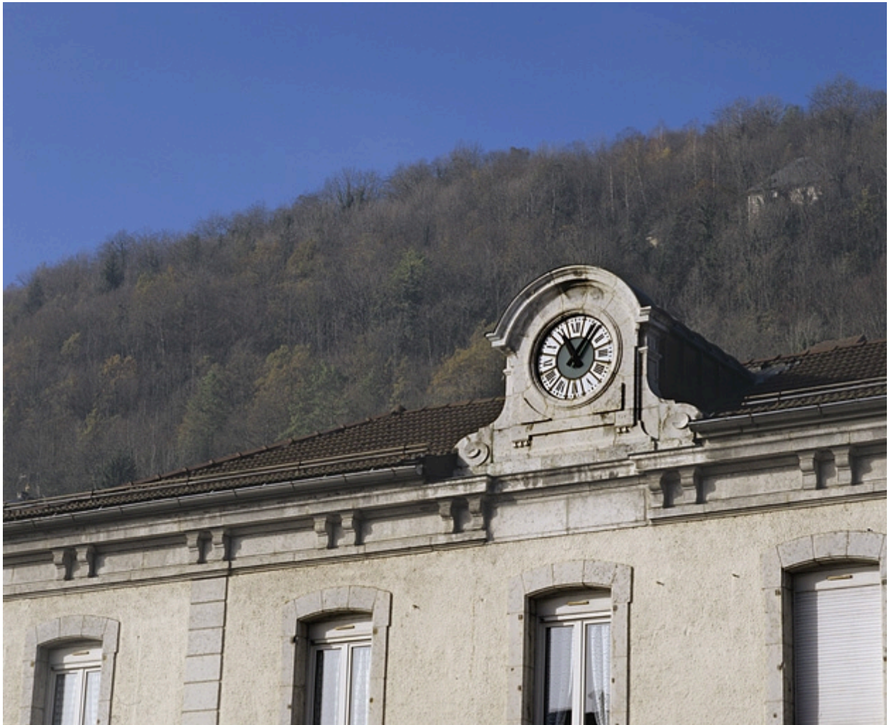
Bâtiment des voyageurs : horloge sur la façade antérieure.
