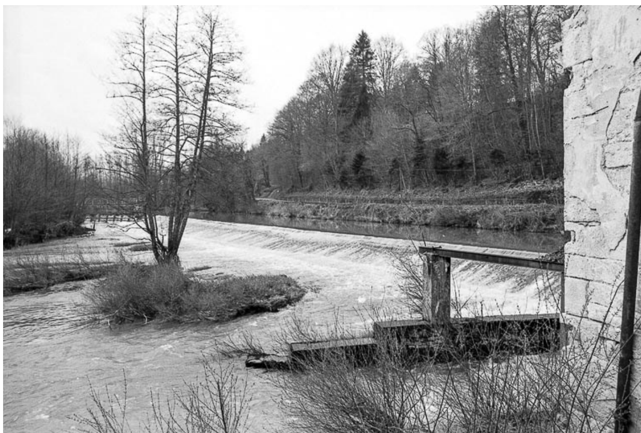
Le barrage depuis la papeterie en 1979.
