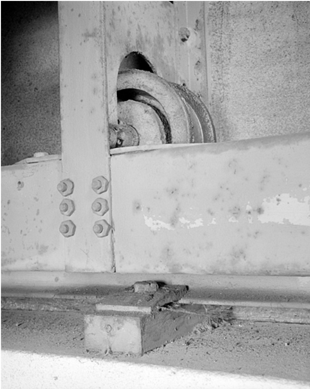
Détail du système de rotation de la coupole : galet.
