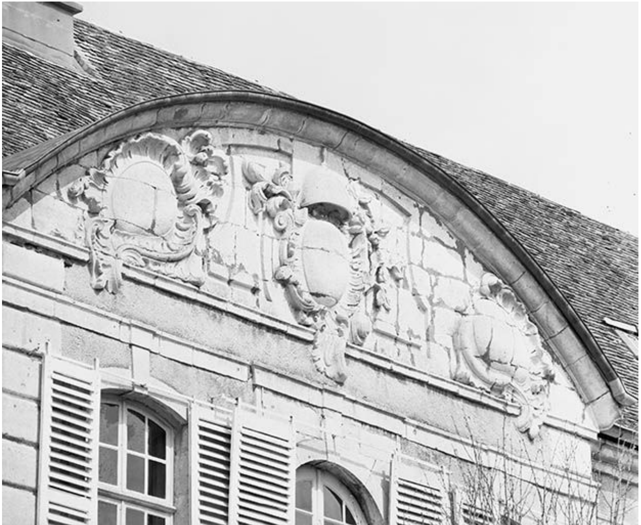
Façade antérieure : le fronton.
