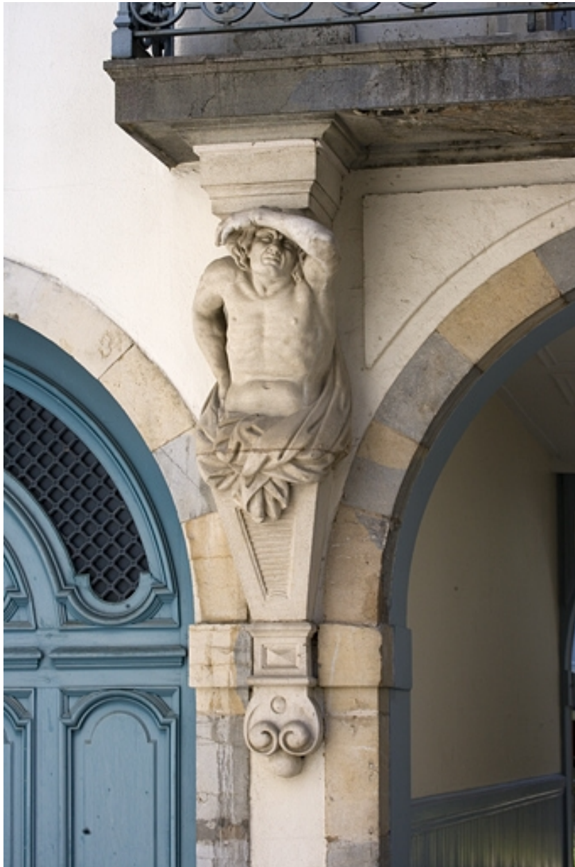
Détail de l'atlante gauche supportant le balcon du logis en fond de cour, de face.
