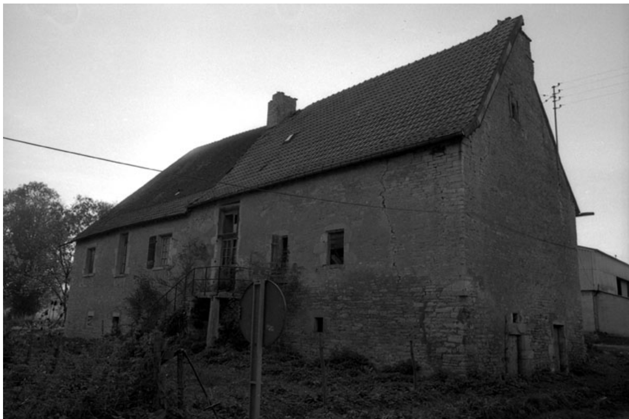
Partie agricole : façade postérieure.
