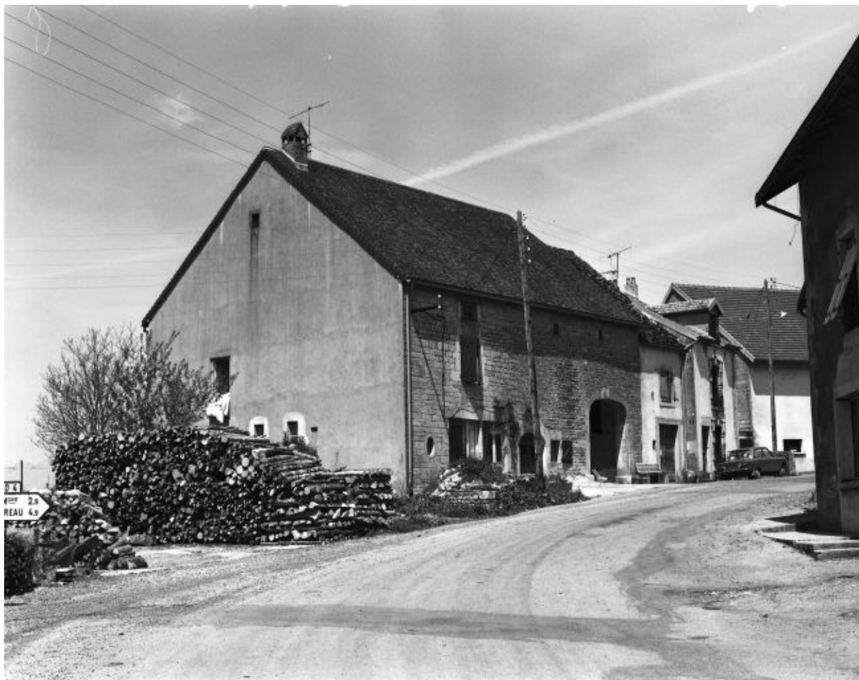
Façade antérieure vue de trois-quarts gauche en 1981.
