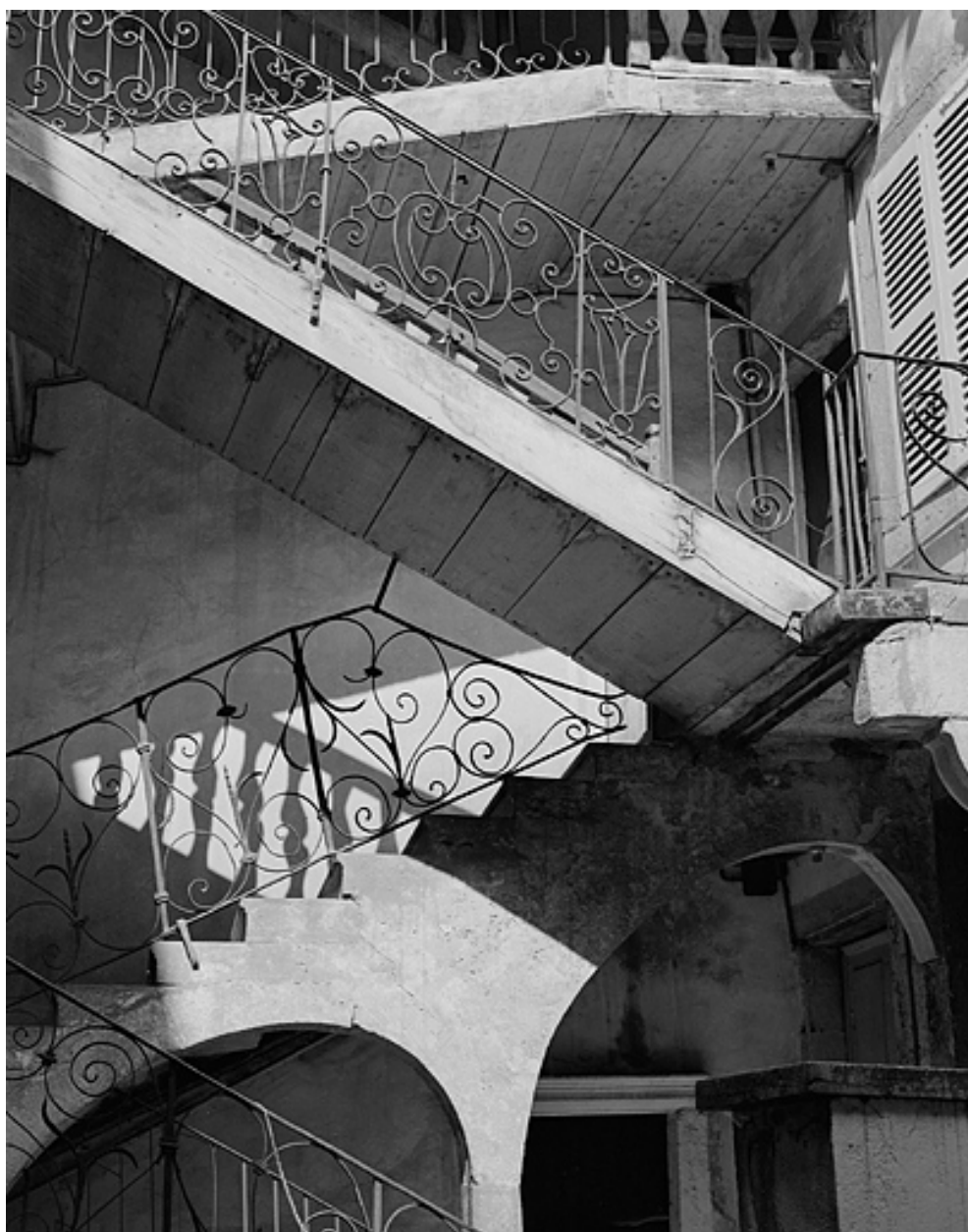
Escalier dans la cour, détail des rampes.
