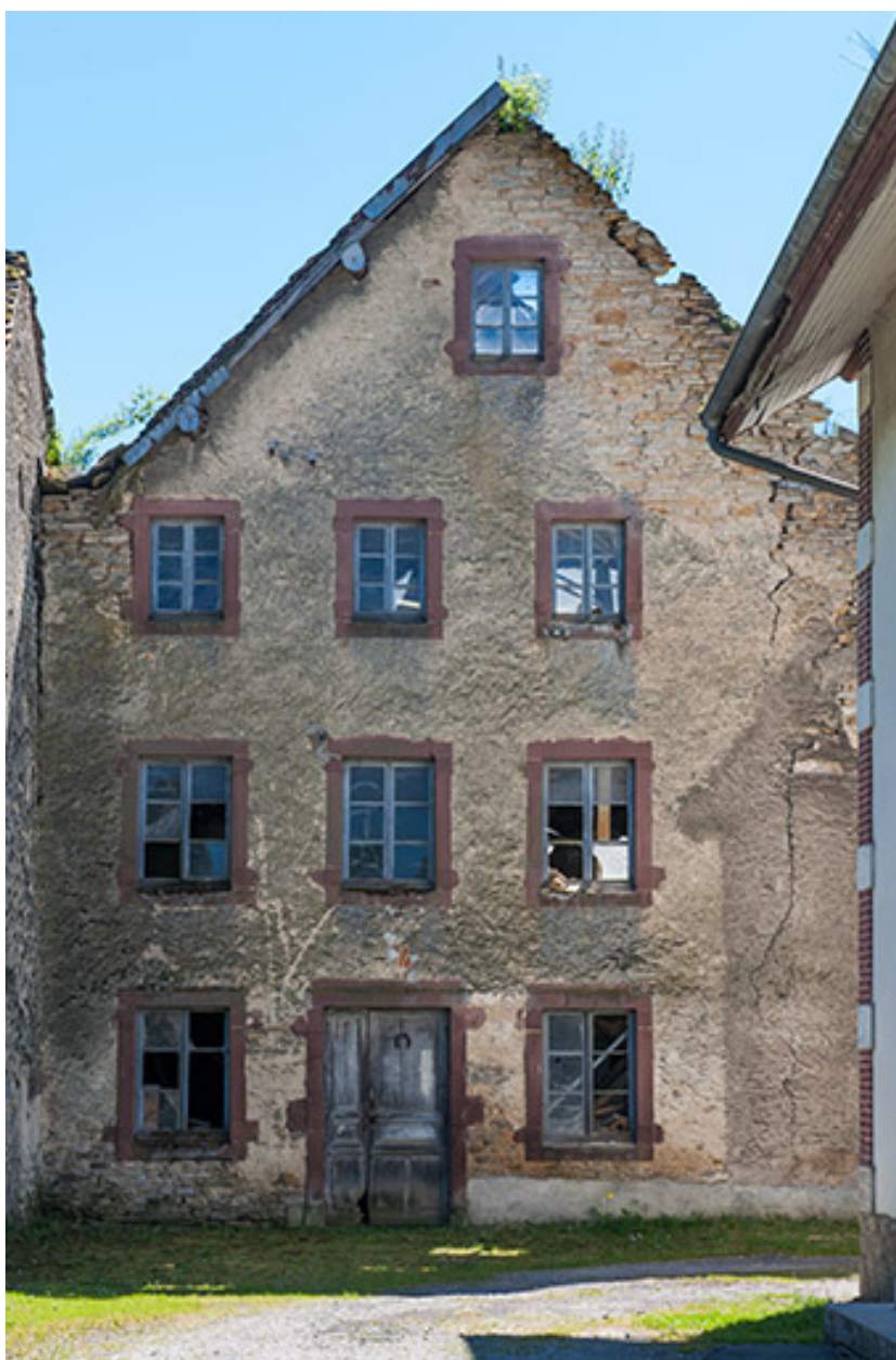
Pignon nord du moulin.
