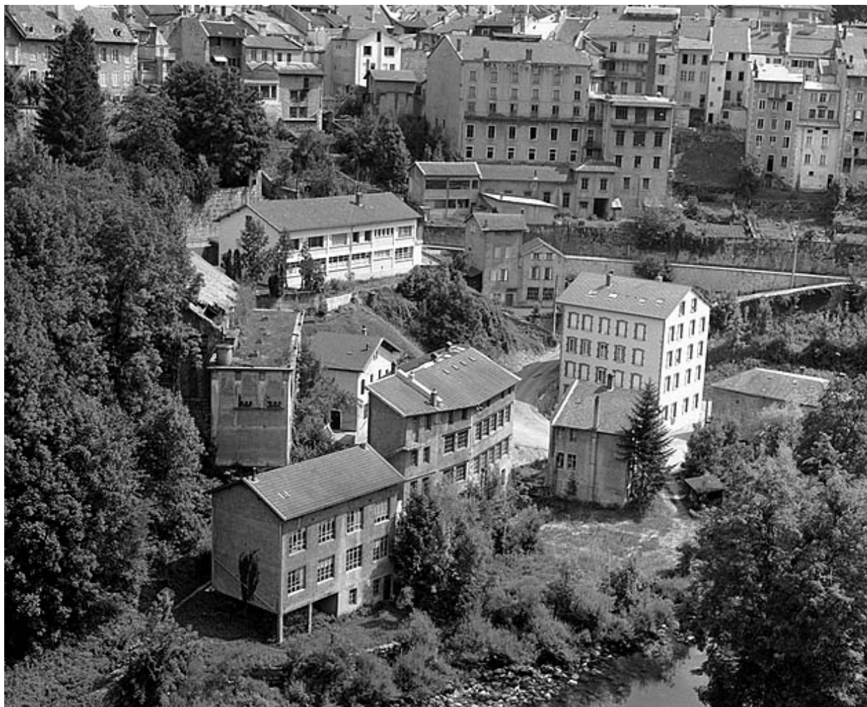
Vue d'ensemble rapprochée depuis le nord-ouest.
