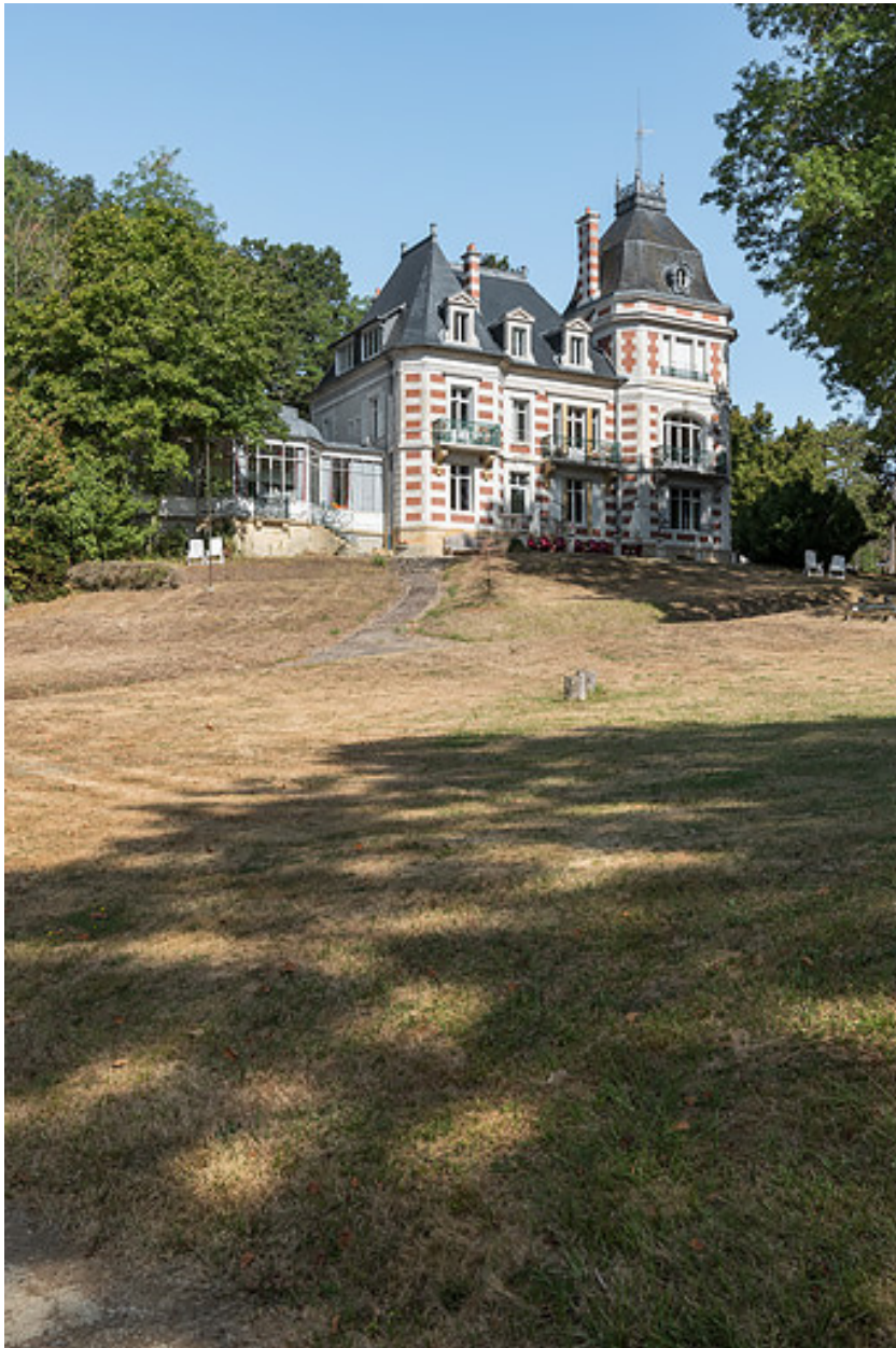
Façade, vue de trois-quarts depuis le sud.
