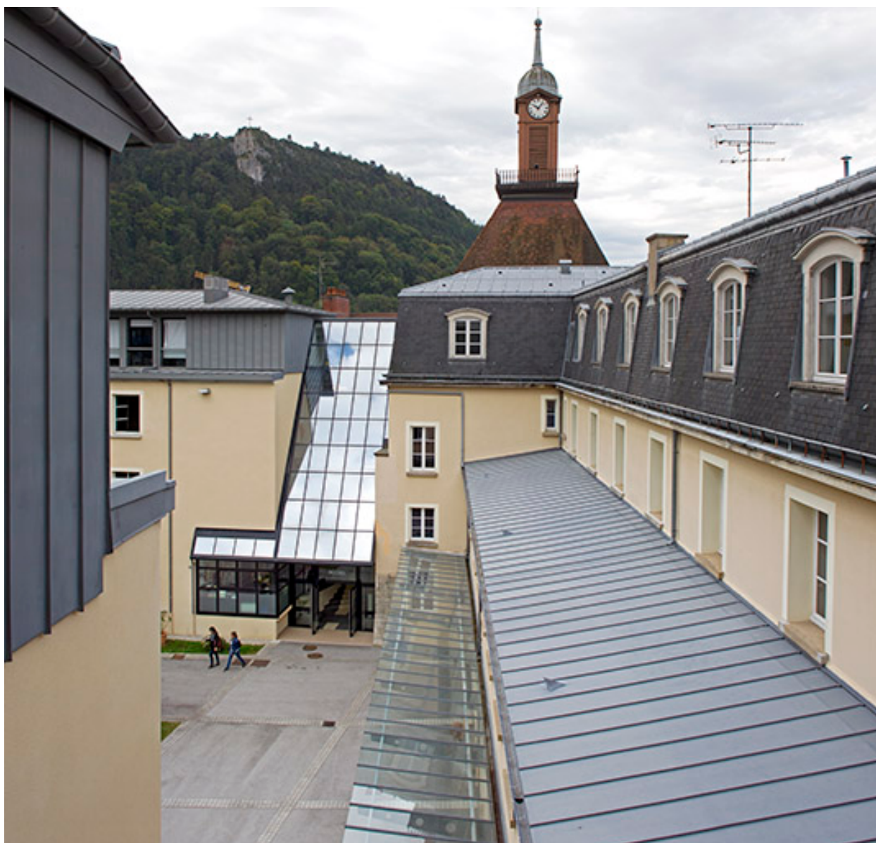
Aile Ouest : toitures at auvents.
