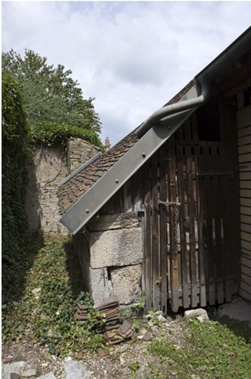
Détail du creux à fumier et du toit à porcs.
