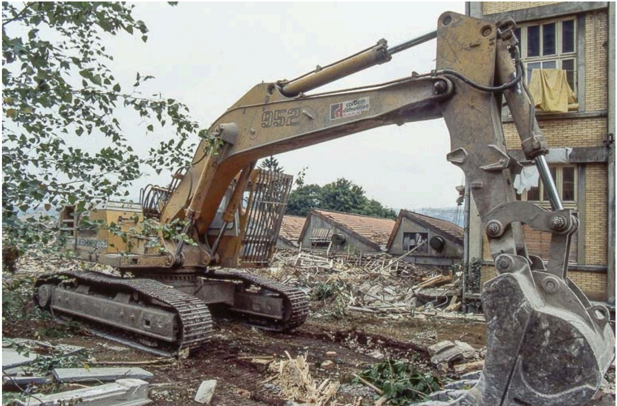
Destruction de l'usine, 23 août 1993 : pelle mécanique.
