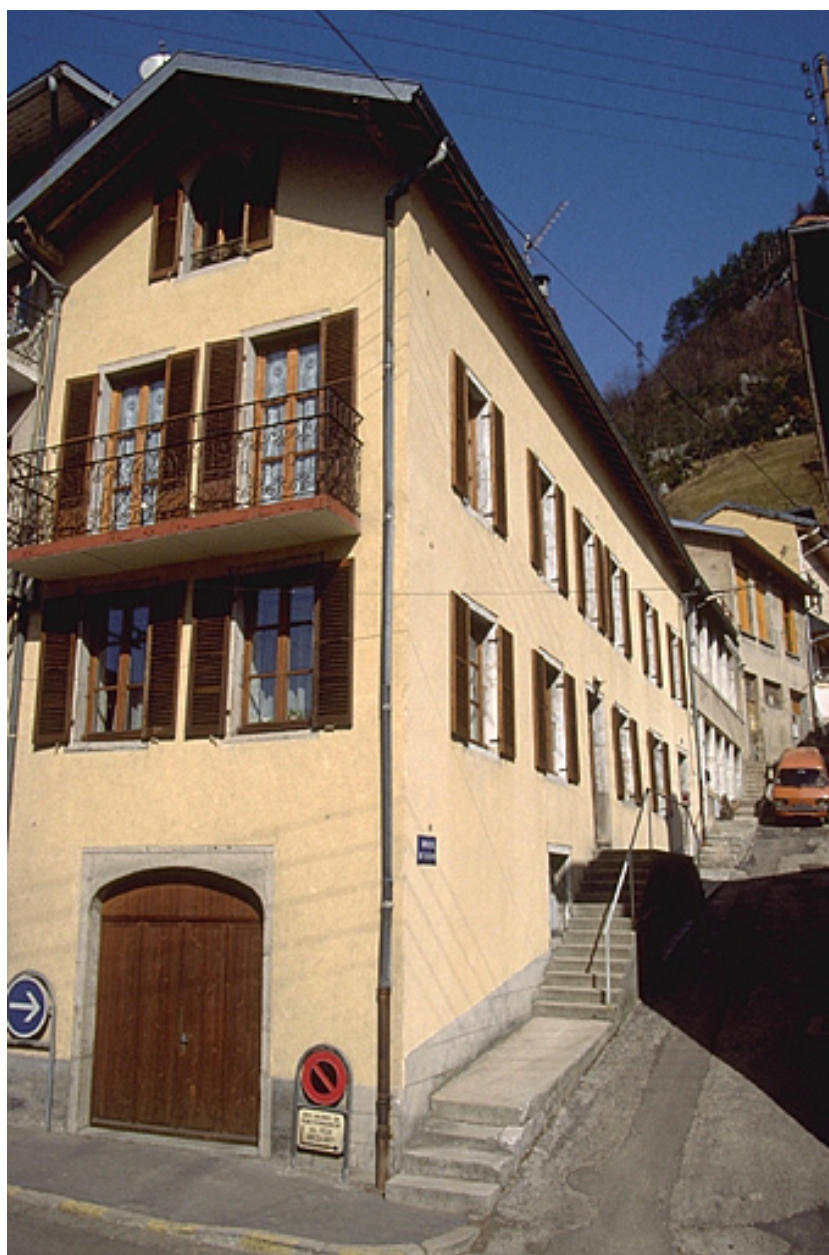
Vue d'ensemble depuis la rue Rosset.
