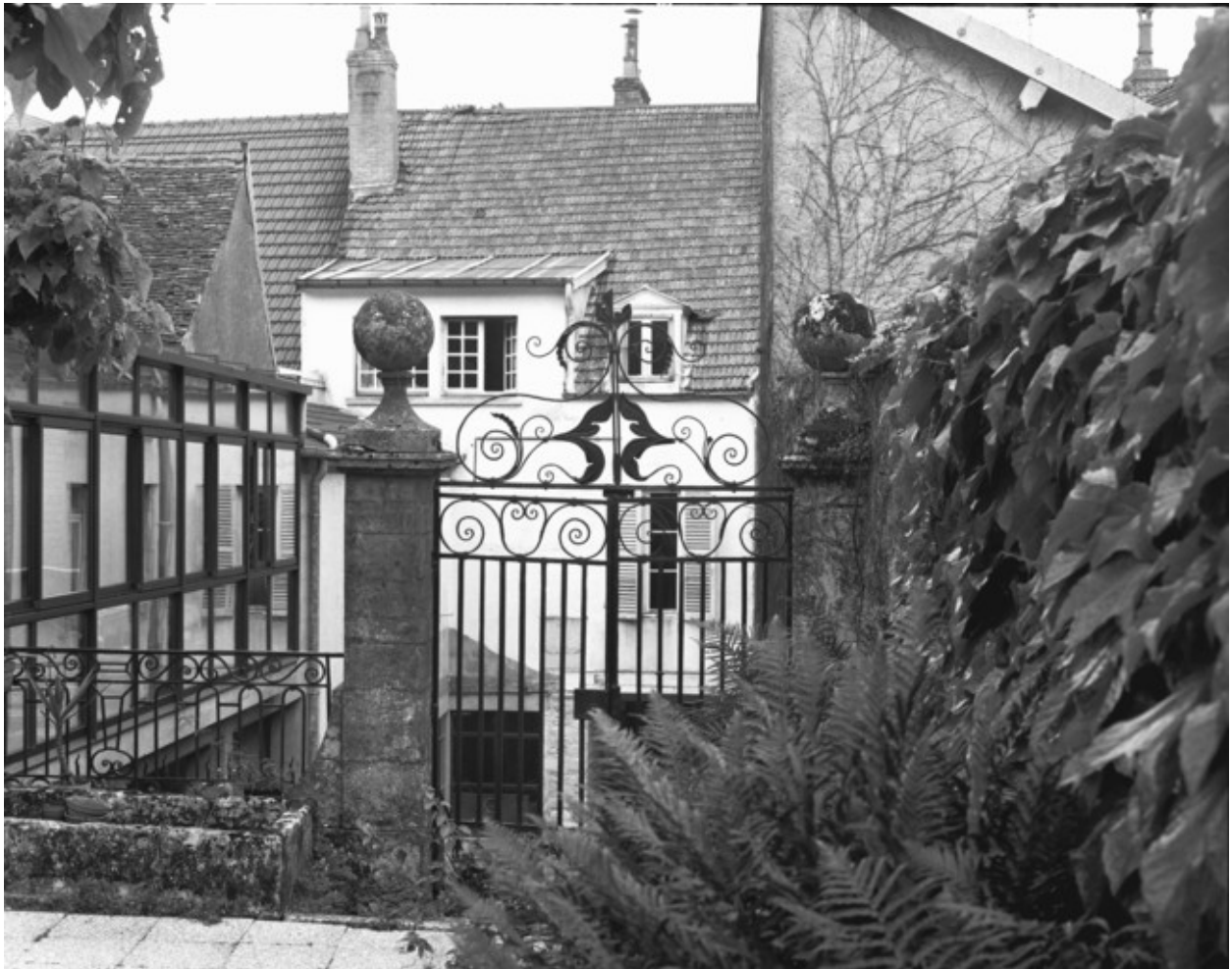
Détail de la grille d'entrée du jardin.
