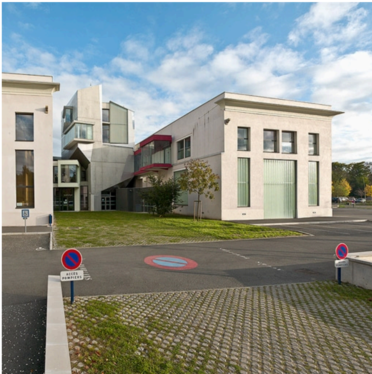
Vue extérieure, façade postérieure.
