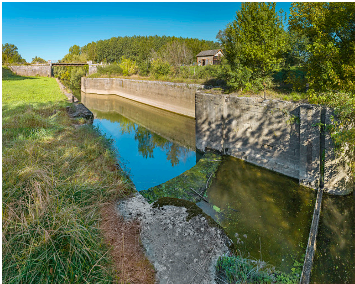
Le sas et l'emplacement des portes.
