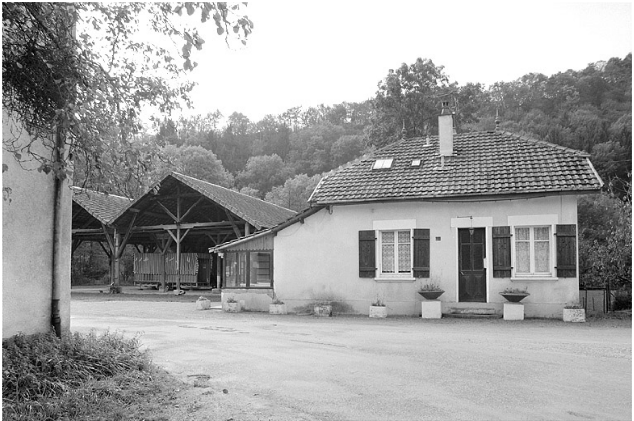
Façade nord de la conciergerie.
