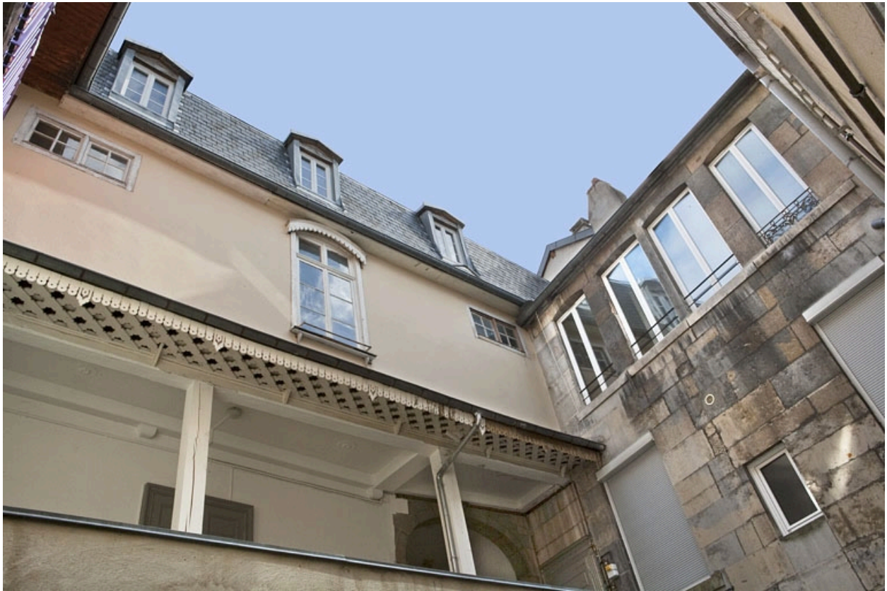
Détail d'une partie du dernier étage des façades sur cour.
