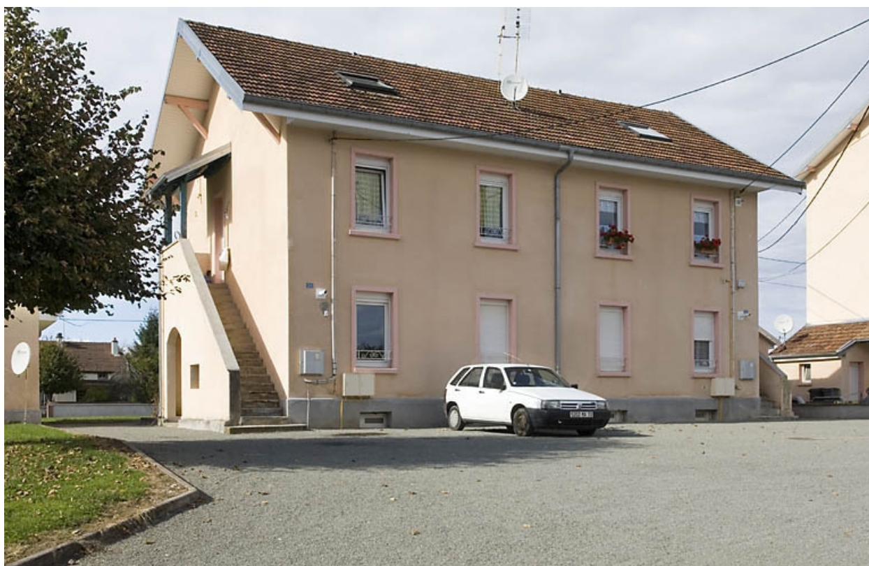
Logement ouvrier. Vue de trois quarts.
