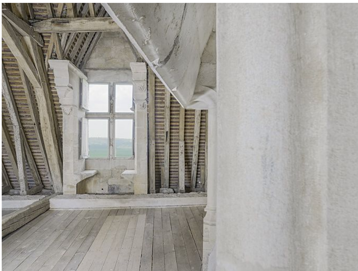
Combles : au-dessus du grand logis, partie droite. Fenêtre à montants sculptés.
