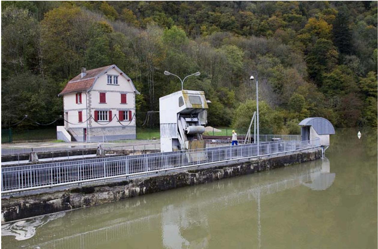
Prise d'eau : grilles de protection du bassin et dégrilleur.
