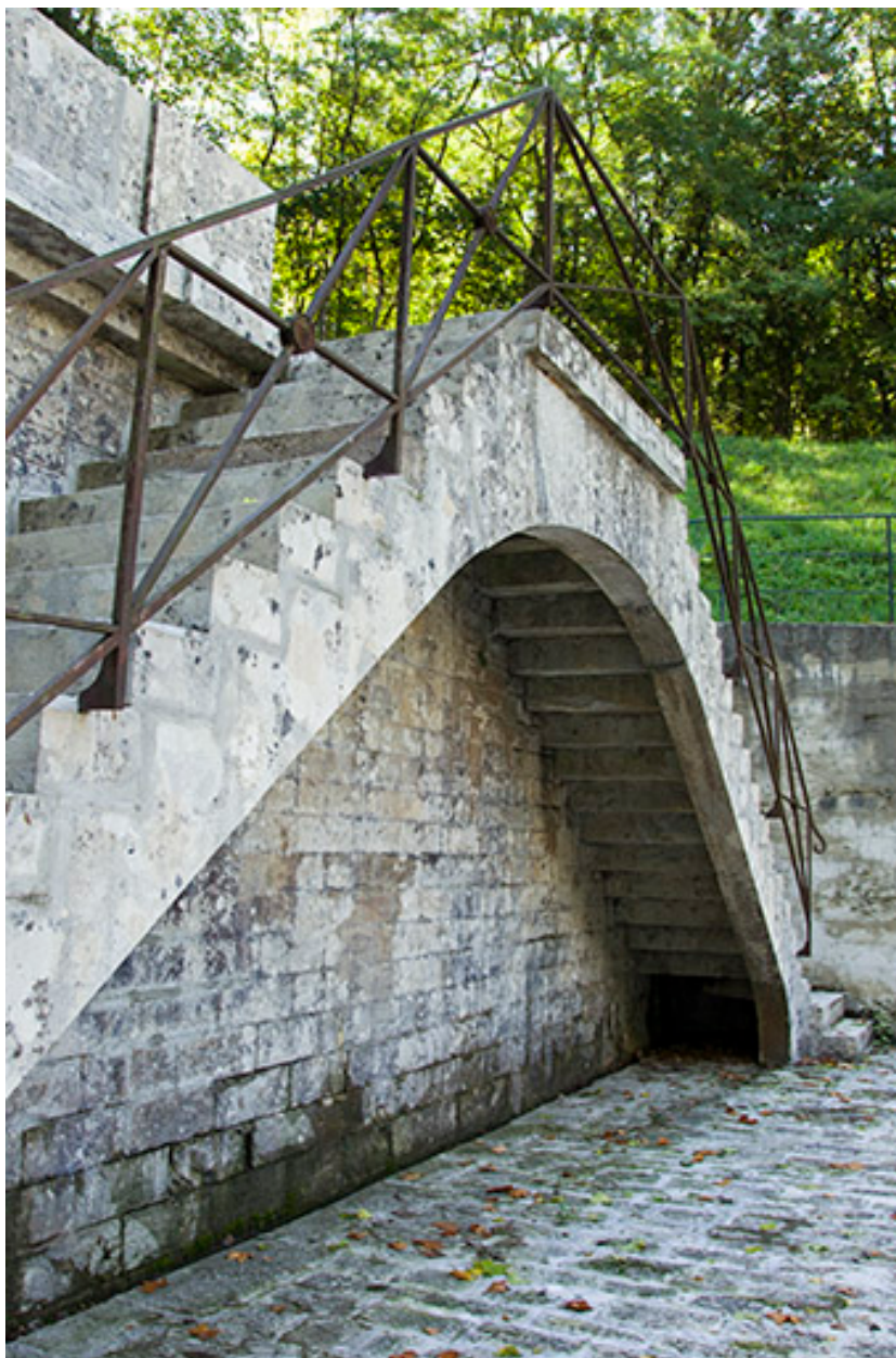
Escalier double, terrasse surplombant l'entrée du souterrain.
