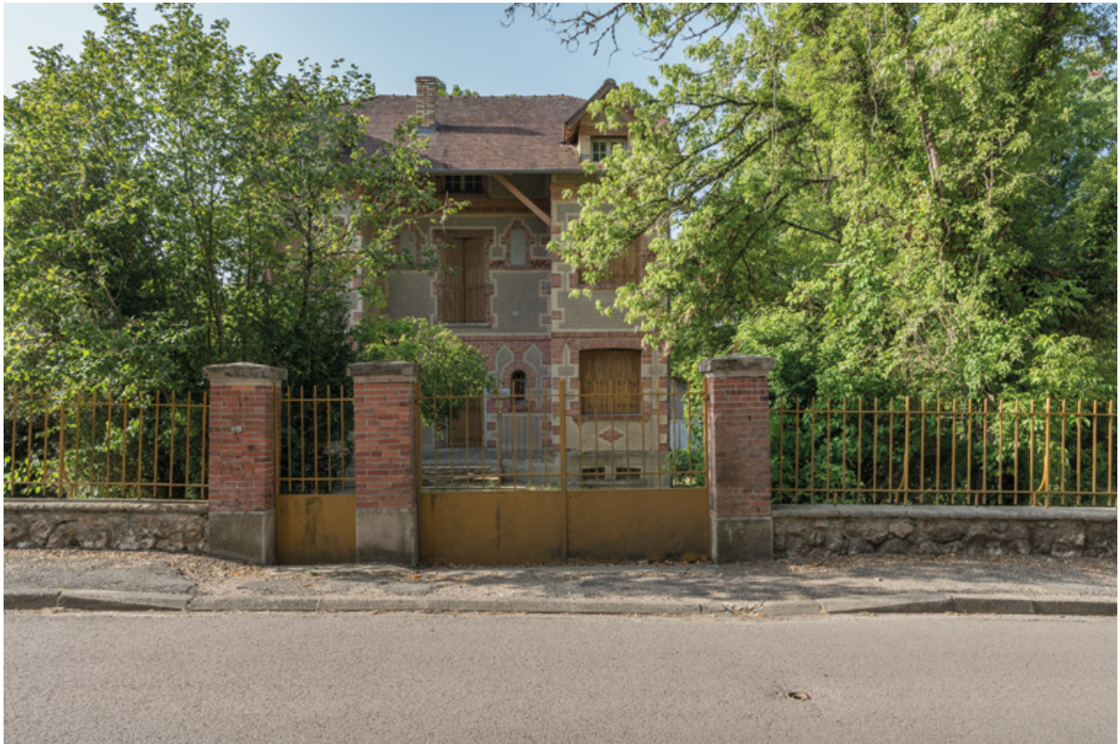
Situation de la villa sur l'actuelle avenue Jean Mermoz, vue de face.
