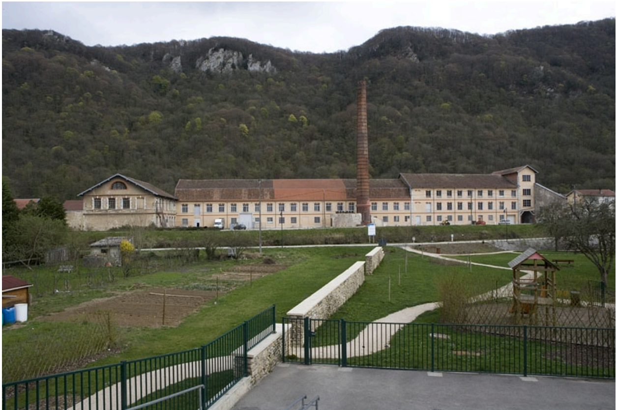
Façades ouest des ateliers.
