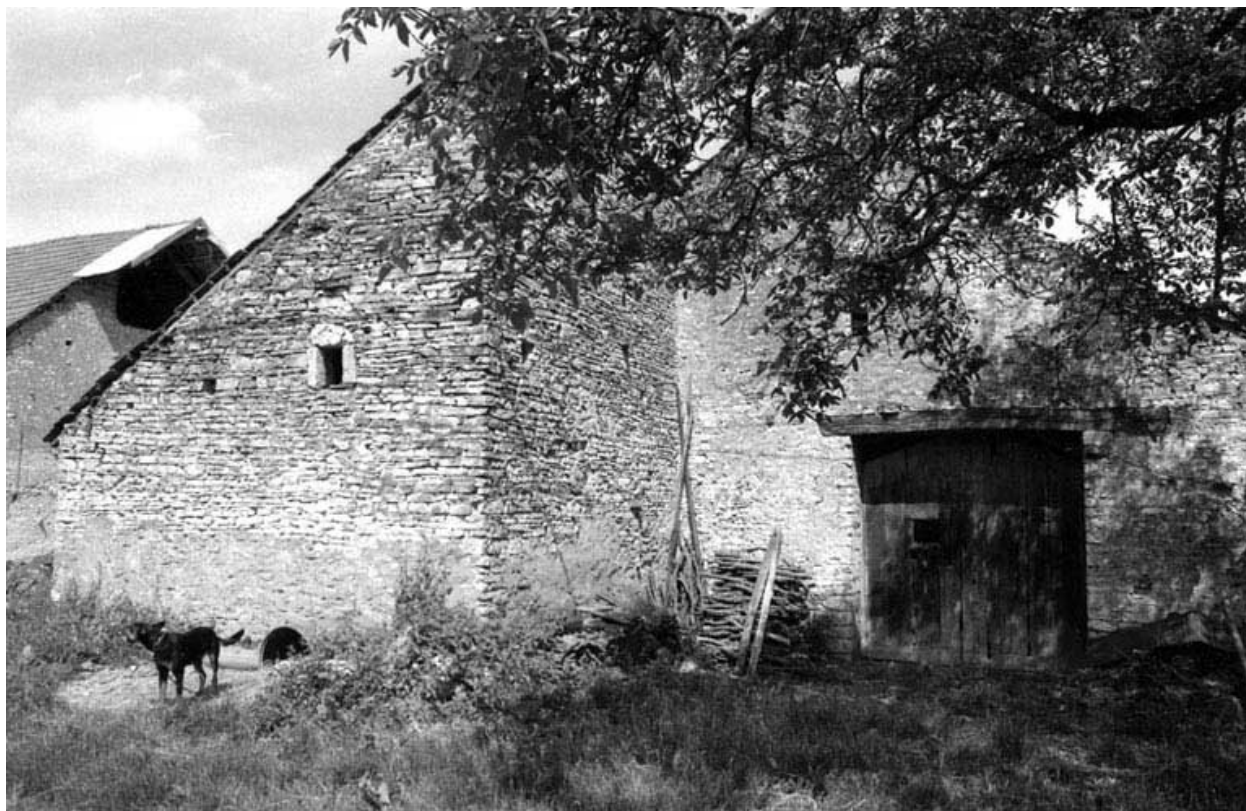
Remise et four : façade sur rue.
