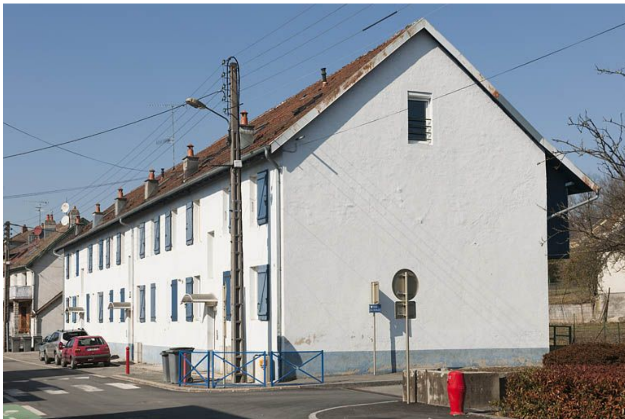
Immeuble de 12 logements vu depuis le sud-est.
