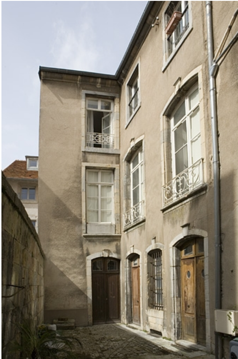
Vue d'ensemble de la cour secondaire donnant sur la rue de la Bibliothèque.
