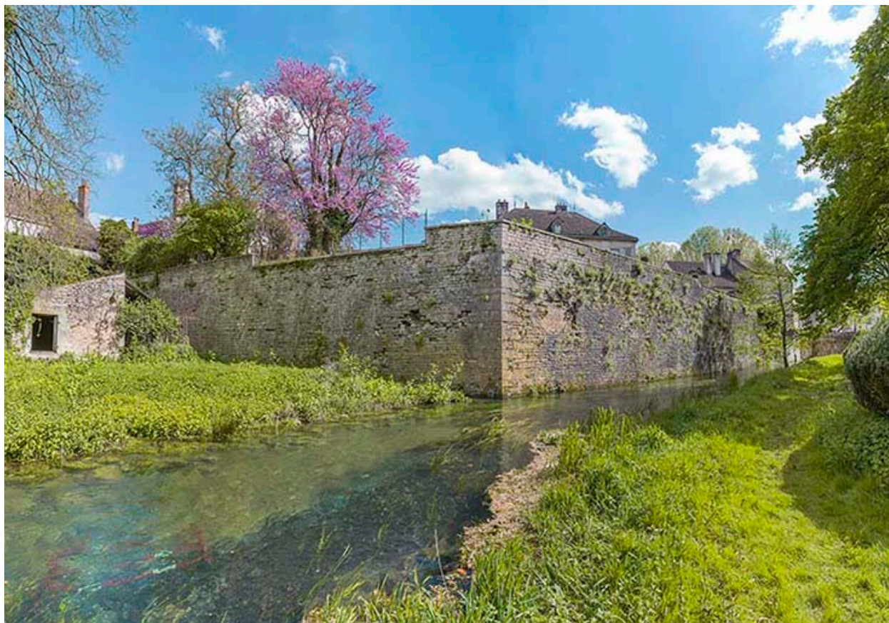
Bastion Bretonnière ou bastion Condé.
