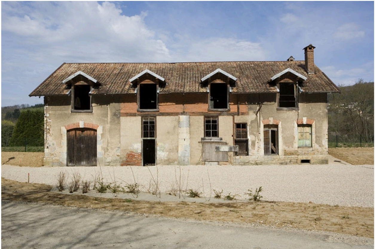
Façade est de l'écurie.
