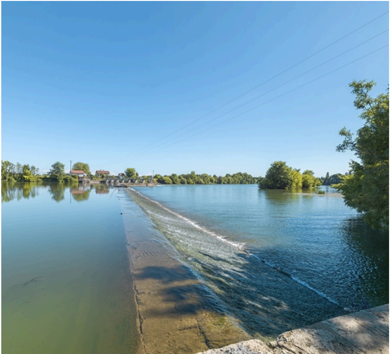
Le déversoir du barrage.
