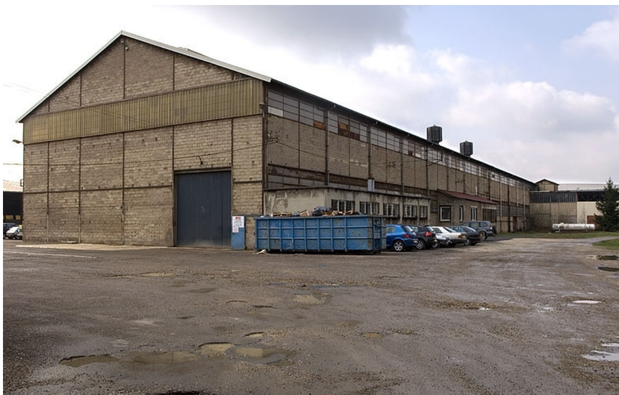
Atelier de fabrication depuis le nord.
