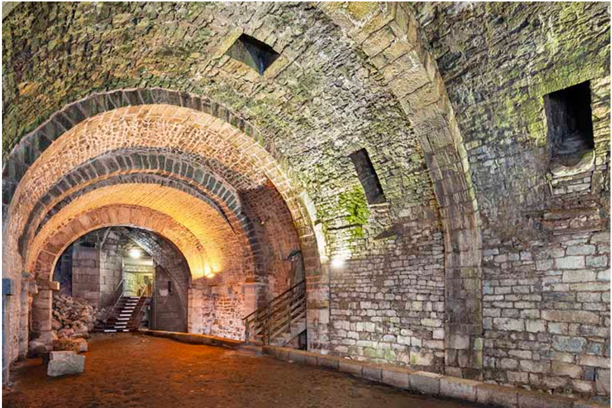
Puits d'Aval. Vue rapprochée depuis le nord-est.
