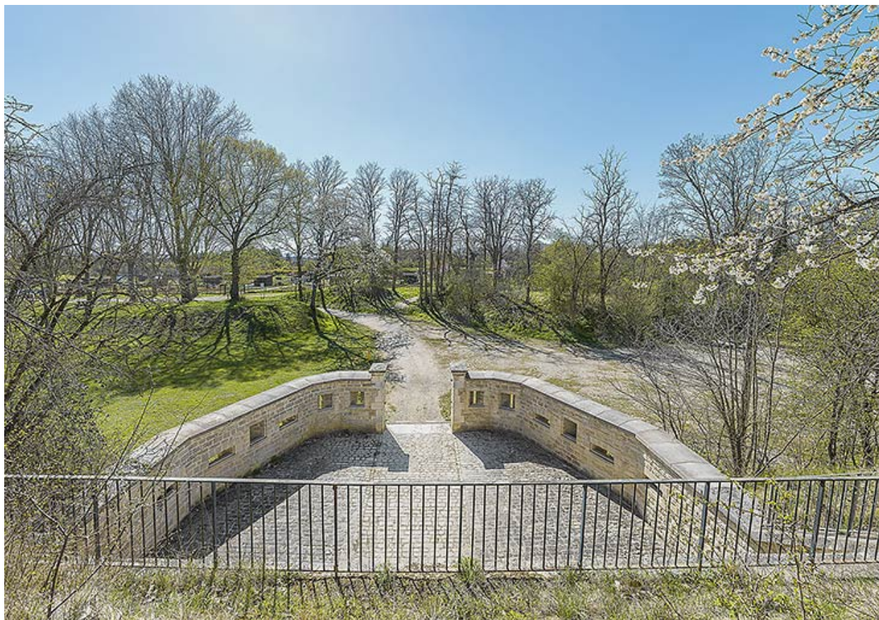
Le ravelin depuis la terrasse des casernes.
