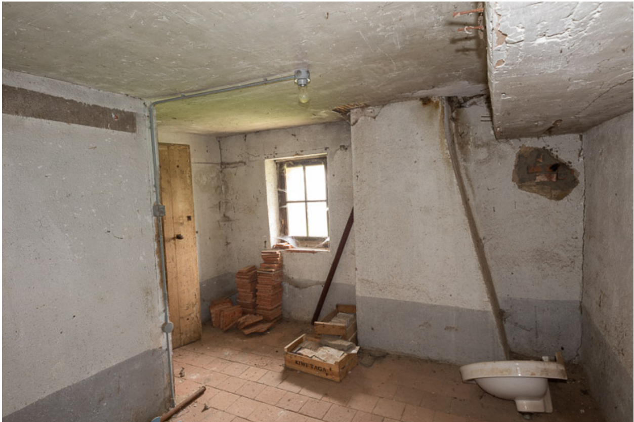
Chambre de domestique au-dessus de la chambre du four à pain (boulangerie)
