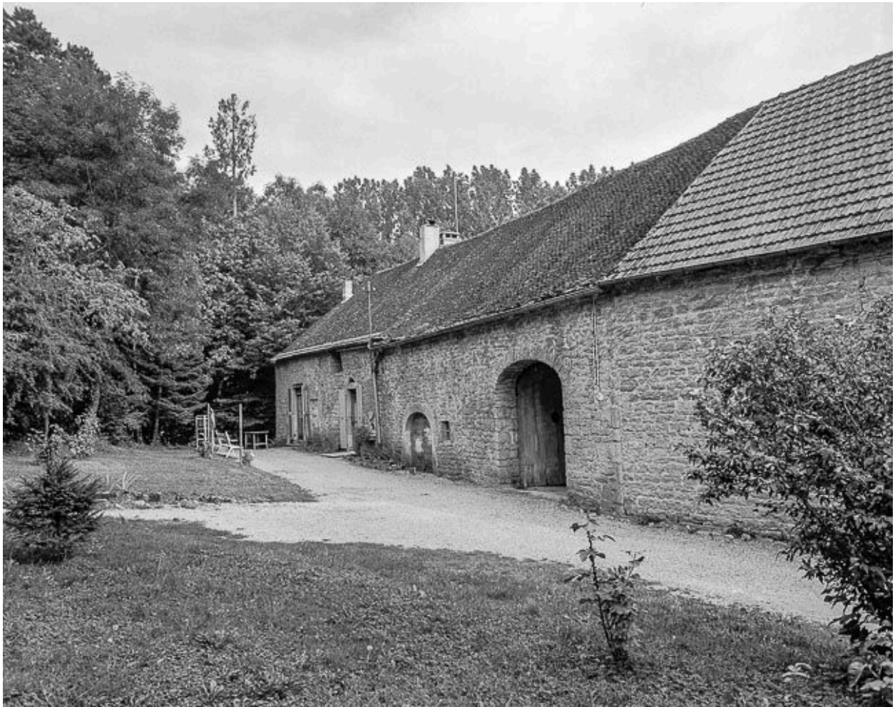
Façade sur cour.
